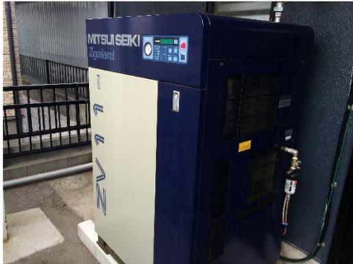
3年前に導入したインバーター方式コンプレッサーより無駄な稼動と大幅な電力の削減につながっている。
